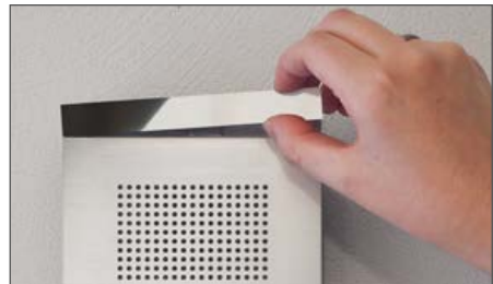
2 Edelstahlstreifen entfernen
