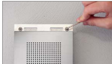
3 Türstation anschließen und befestigen
